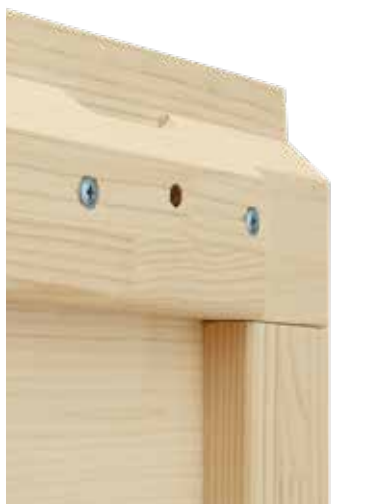
Extrémités des sections renforcées
